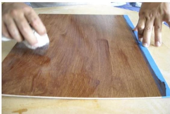
距第一度上油後約 24 小時(視溫度與濕度而定)，並觀察第二度完全乾燥後，即可進行第三度的施作，以湯匙滴適量的護木油於表面，或以乾淨的軟布沾少量之護木油，均勻推散同時拋光。
